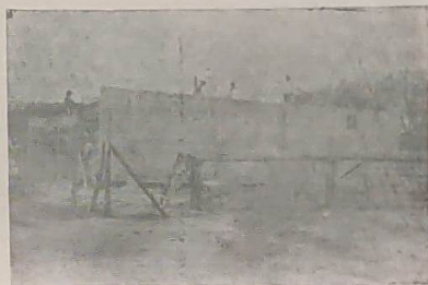
Obras da Unidade Mista de Saúde estão em fase adiantada.
